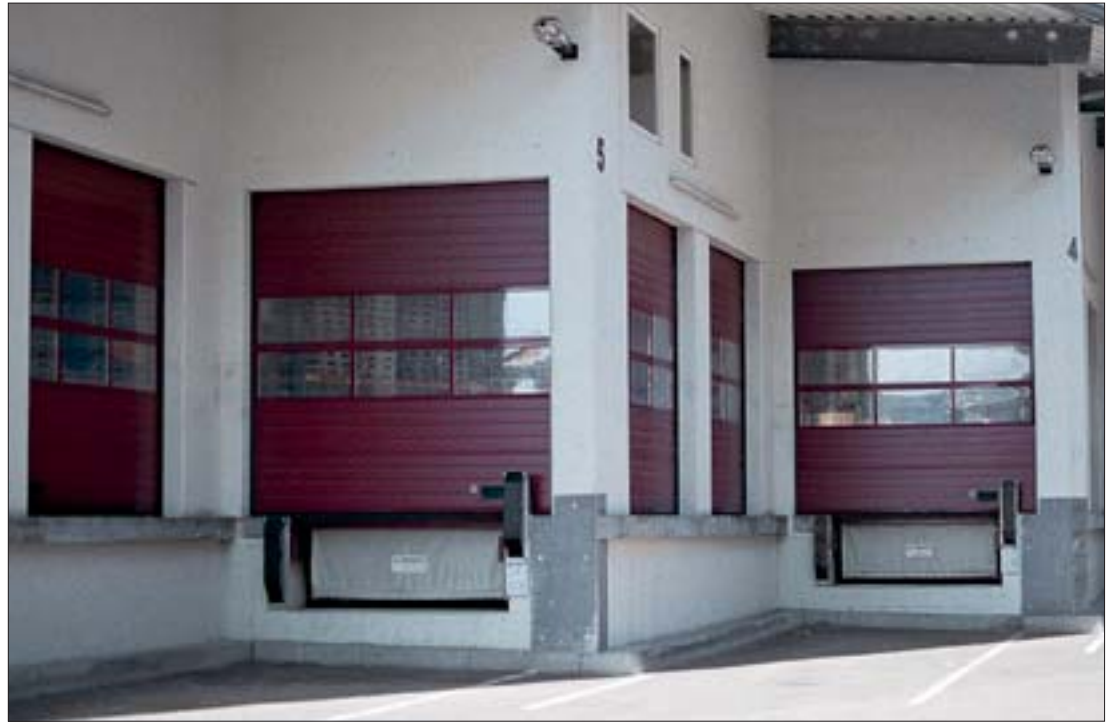
Simplex-Federstahlpufferung kombiniert mit elektrohydraulischer Anpassrampe.
